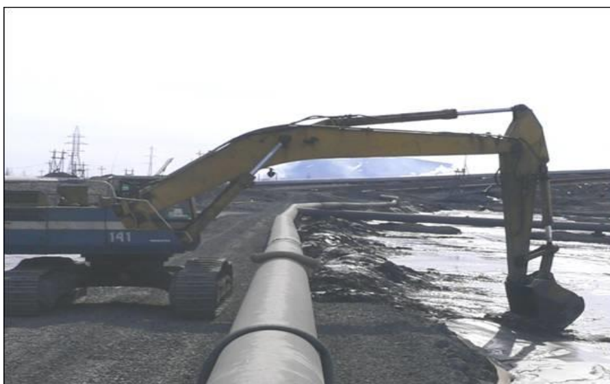
Рисунок 4.9 - Обвалование опорной призмы пульпопровода
