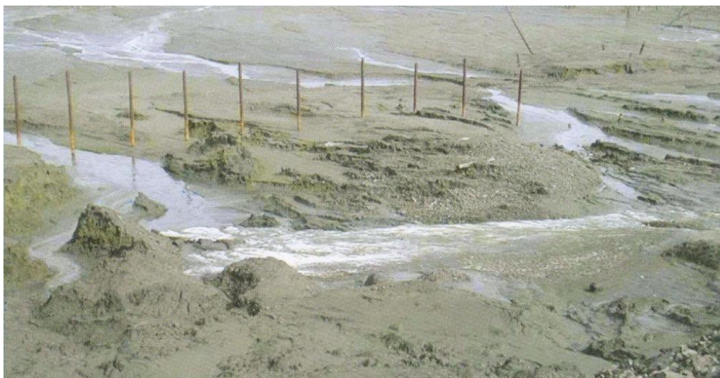
Рисунок 4.2 Контрольные марки в зоне намыва
