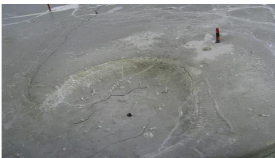
Рисунок 3.4 -Воронки под выпусками и характер пляжа.
