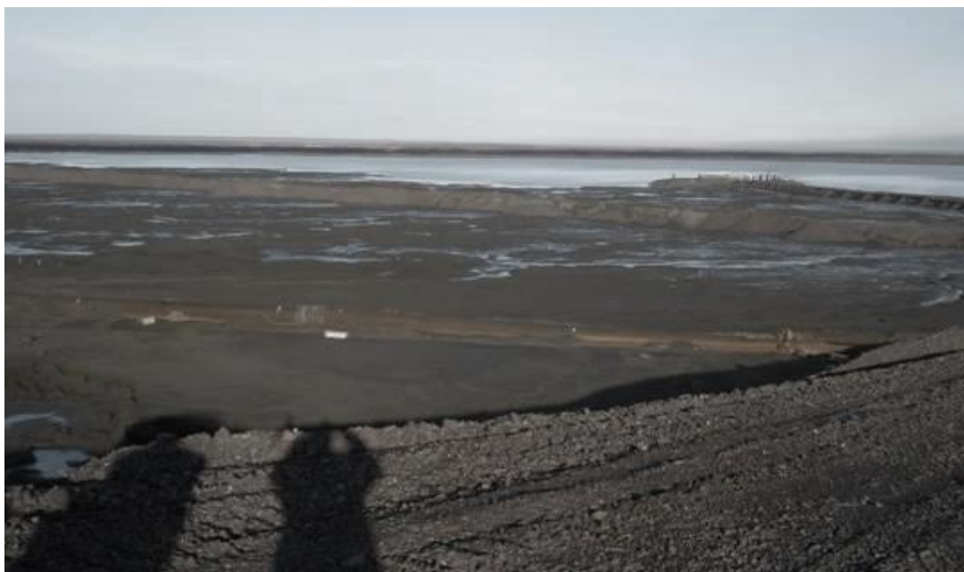
Рисунок 4.6 - Дренажная призма пригрузки низового откоса разделительной дамбы
