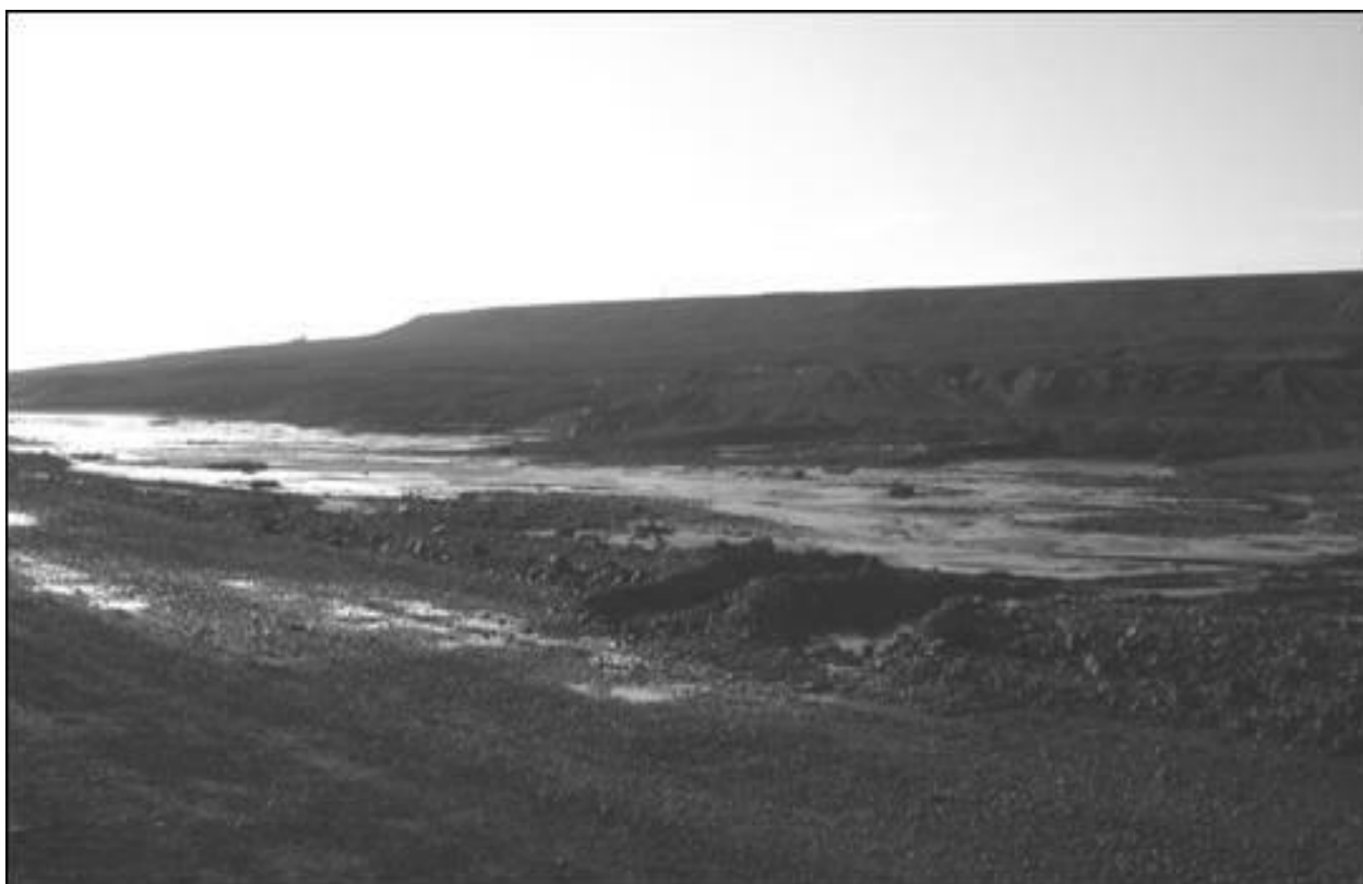
Рисунок 4.3. - Фильтрация на участке низового откоса восточного борта хвостохранилища
