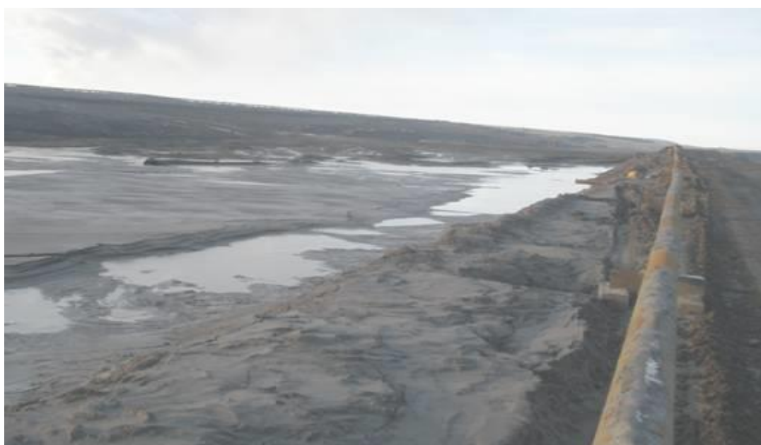
Рисунок 4.10 - Площадь для складирования хвостов в низовой откос разделительной дамбы
