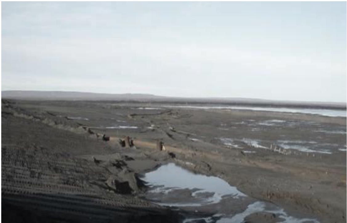
Рисунок 4.4 - Выположенный откос разделительной дамбы
